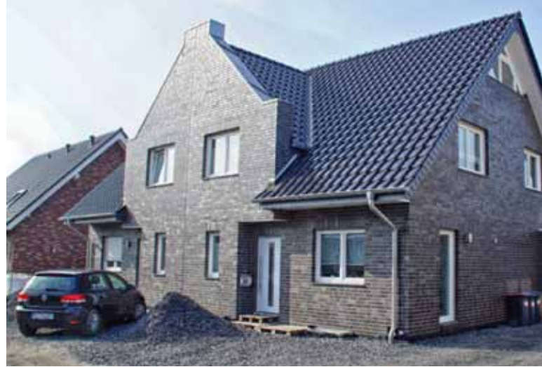
Passivhaus im Münsterland, Doppelhaus www.gabriel-passivhaus.de
